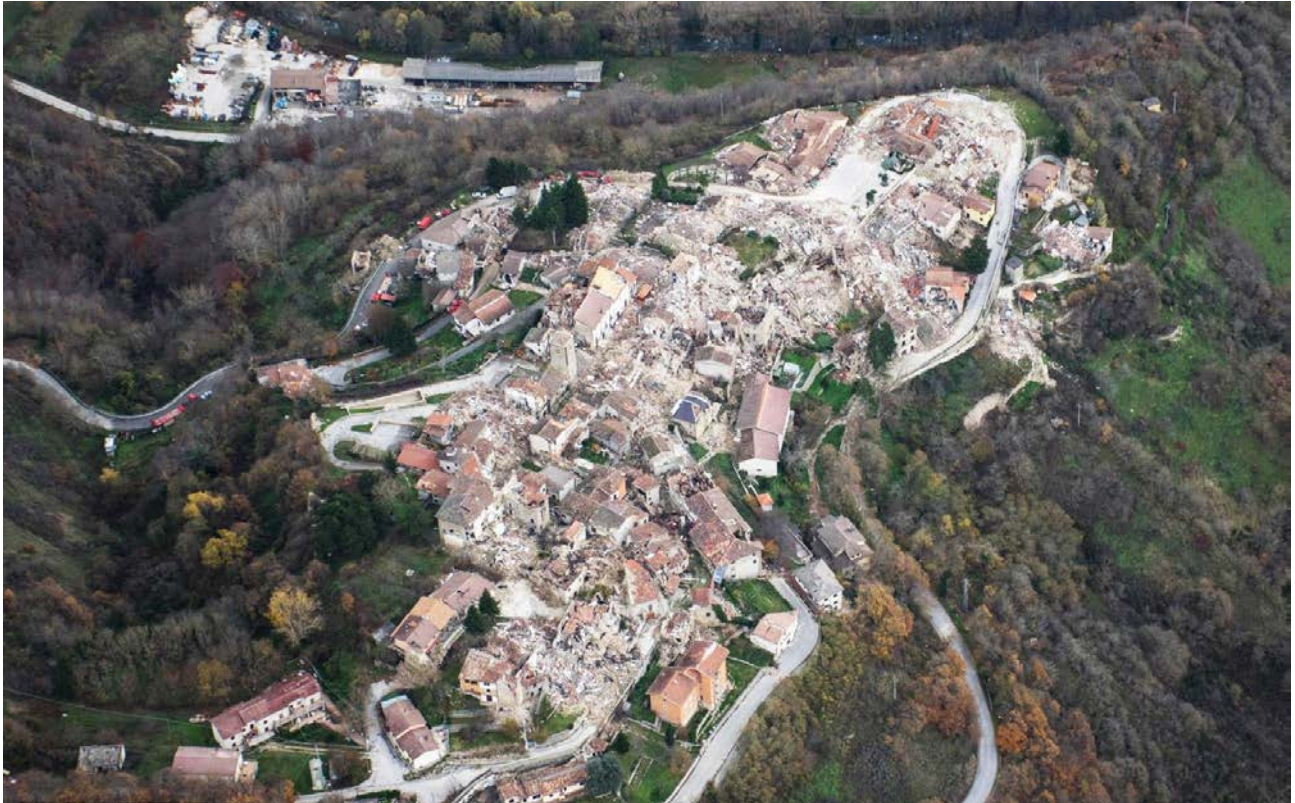
Vista aerea del danneggiamento di Accumoli a seguito dei terremoti del 2016.
