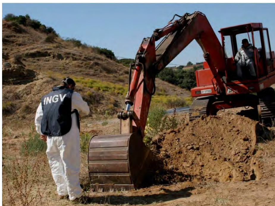
L'INGV è impegnato nelle attività di geofisica ambientale dagli anni '90. Nell'immagine il personale segue i lavori per uno scavo a seguito dell'individuazione di rifiuti interrati di natura ferromagnetica (fusti, cisterne, ecc.). Tali masse vengono rilevate attraverso prospezioni geofisiche impiegando magnetometri a pompaggio ottico. Le cartografie delle anomalie magnetiche così realizzate permettono di individuare con estrema precisione i corpi inquinanti presenti nel sottosuolo (foto di repertorio INGV).
