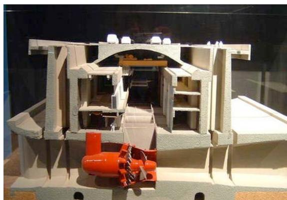
**Figura 67.** Sezione dell'impianto sul fiume Rance (fonte internet).
