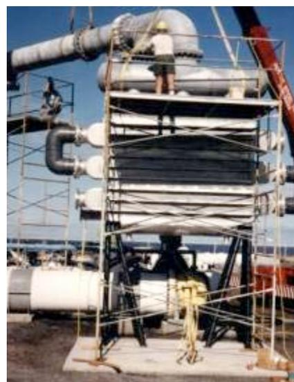
**Figura 84.** Condensatore per produzione di acqua dissalata (fonte NELHA).
