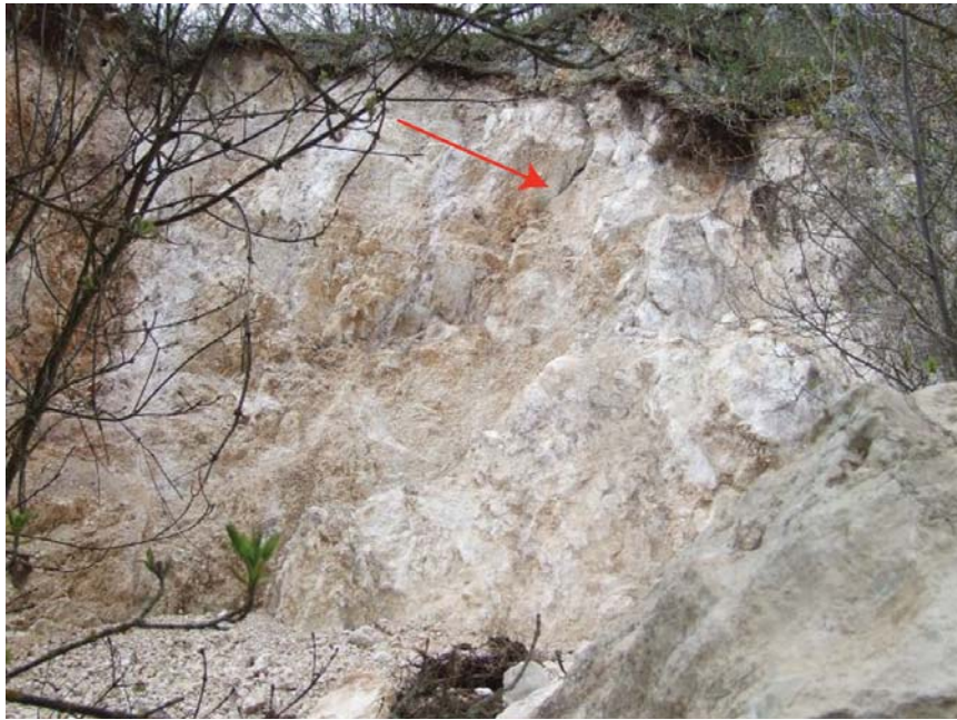
Figura 48 Taglio in roccia con evidenze di fagliazione (WPT RN16, 42.2707/13.5283). Figure 48 Rock outcrop with evidence of faulting (WPT RN16, 42.2707/13.5283).
