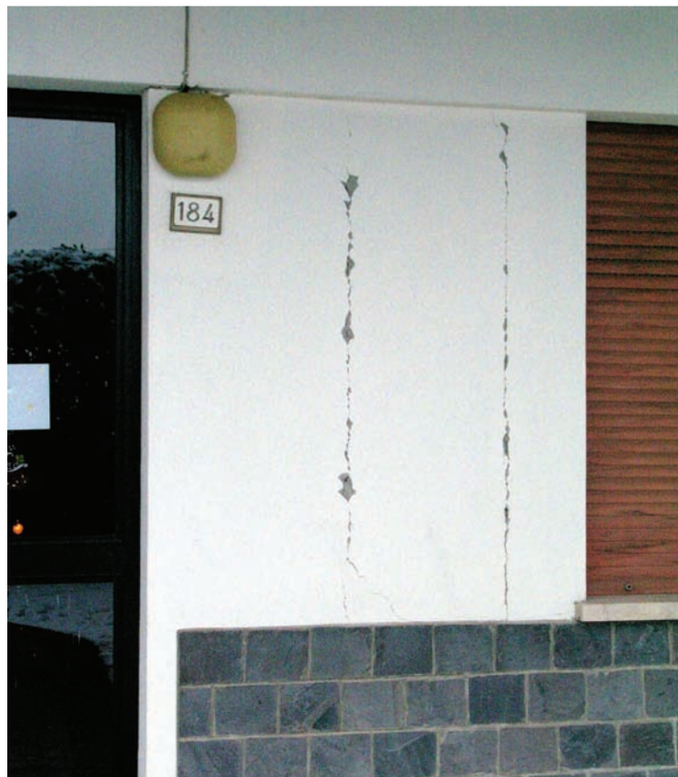
Foto 4 Poggio S. Ilario (Felino): lesioni fra pilastro e tamponatura in un edificio in c.a.. Photo 4 Poggio Sant'Ilario (Felino): cracks between column and infill wall in a reinforced concrete building.
