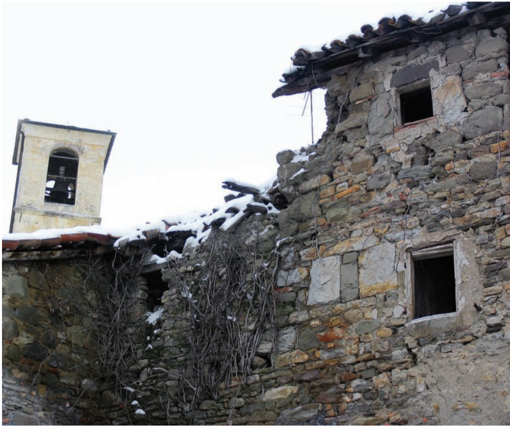
Foto 26 Paderna Chiesa (Vezzano sul C.): crollo parziale in edificio rurale fatiscente. Photo 26 Paderna Chiesa (Vezzano sul C.): partial collapse of a rural poor building.
