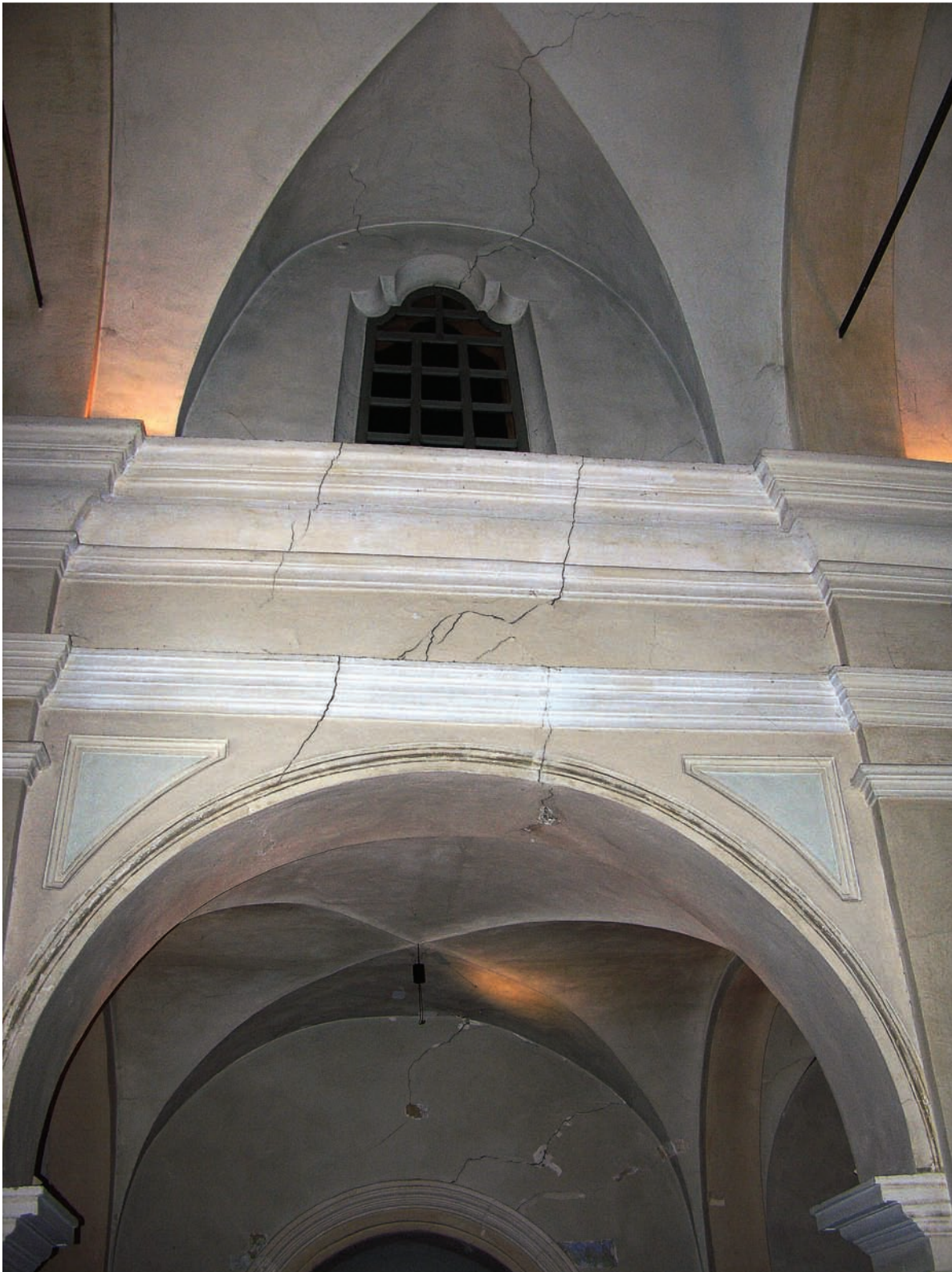
Foto 23 Leguigno (Casina): lesioni diffuse all'interno della chiesa. Photo 23 Leguigno (Casina): extensive cracks in the church.
