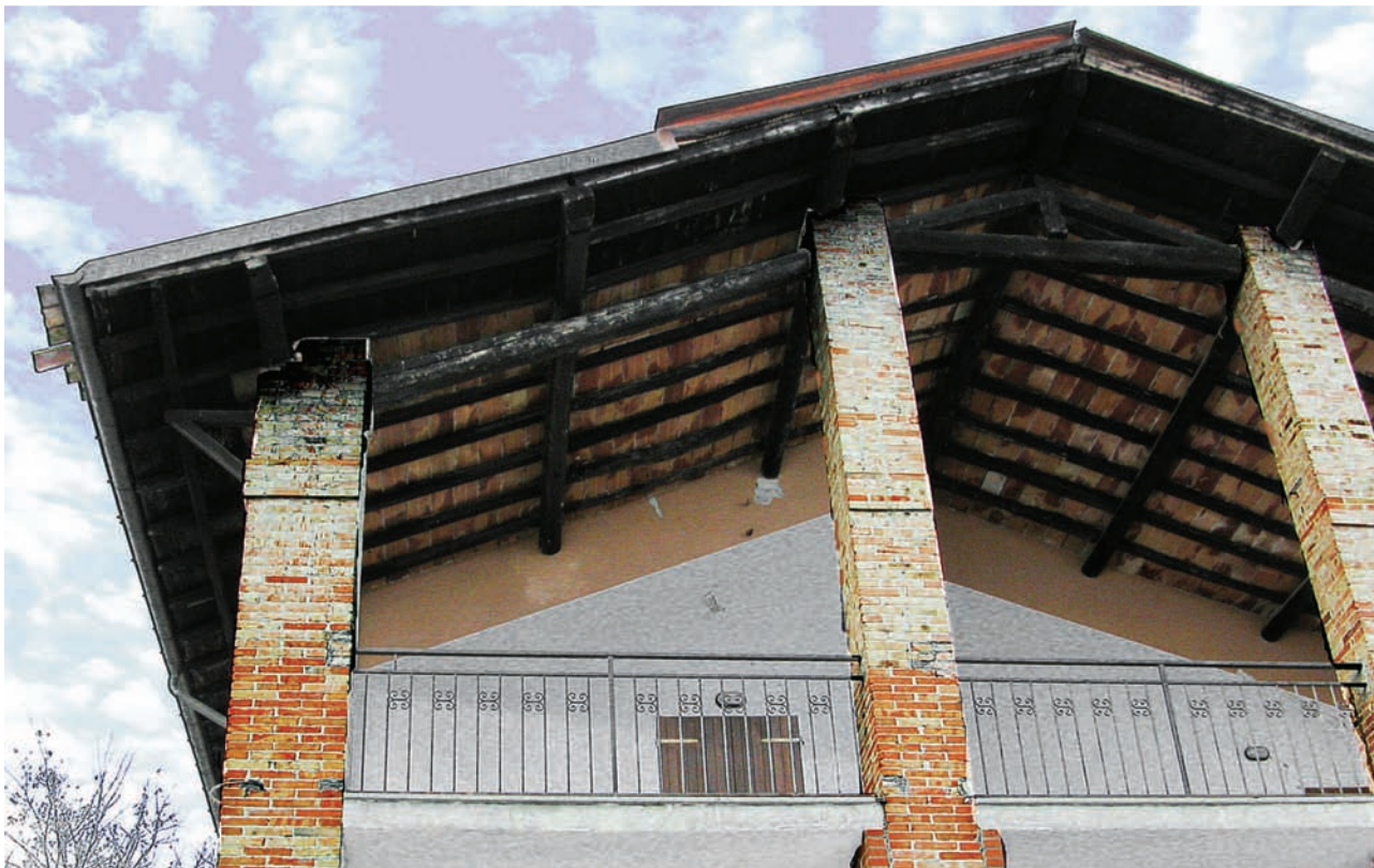
Foto 6 Sant'Ilario Baganza (Felino): Lesioni sulla facciata di edificio in muratura e scivolamento di tegole. Photo 6 Sant'Ilario Baganza (Felino): cracks on the façade of a masonry building with sliding of tiles.
