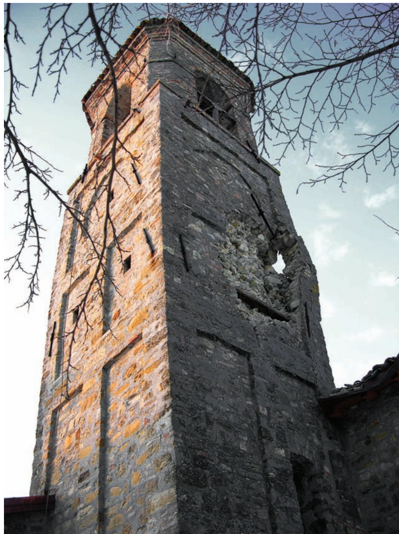
Foto 15 Barbiano (Felino): danni alla torre campanaria, con crollo parziale. Photo 15 Barbiano (Felino): damage at the tower-bell, with fall of part of the external wall.
