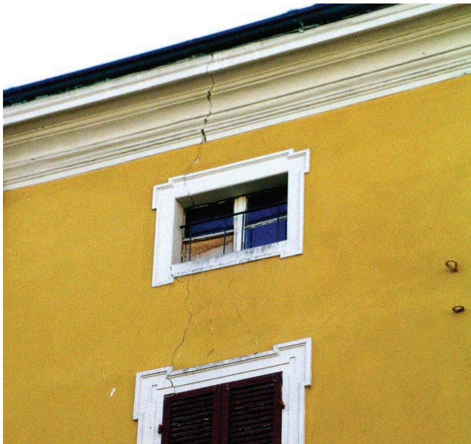
Foto 17 Langhirano: esempio di lesione passante in edificio in muratura. Photo 17 Langhirano: example of serious crack in a masonry building.
