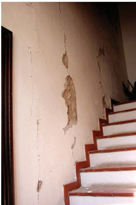
Foto 10 San Vitale di Baganza (Sala B.): edificio privato, lesioni diffuse, distacco di intonaco. Photo 10 San Vitale di Baganza (Sala B.): extensive cracks with fall of plaster in private building.
