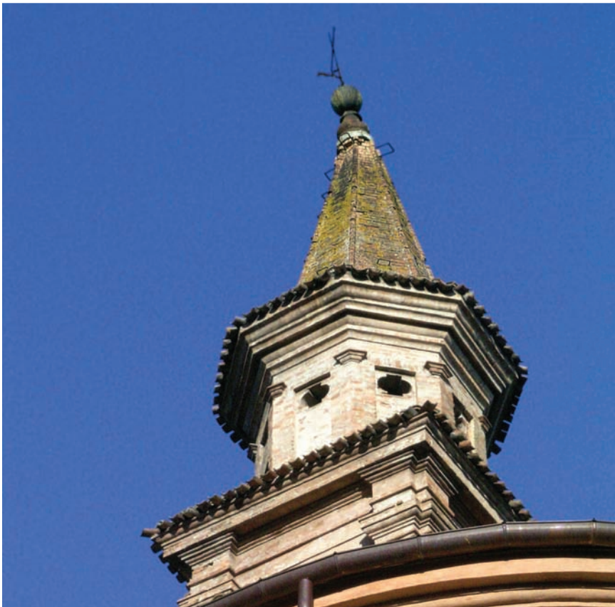
Foto 27 Quattro Castella: chiesa, parziale distacco e pericolo di crollo della parte sommitale della torre campanaria. Photo 27 Quattro Castella: church, partial detachment of the top of the bell tower.
