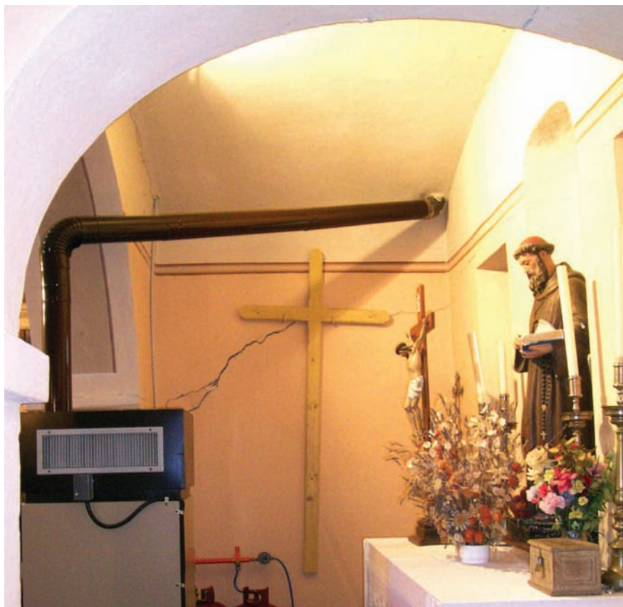
Foto 22 Canesano (Calestano): lesioni nella navata laterale della chiesa. Photo 22 Canesano (Calestano): cracks in the Church aisle.
