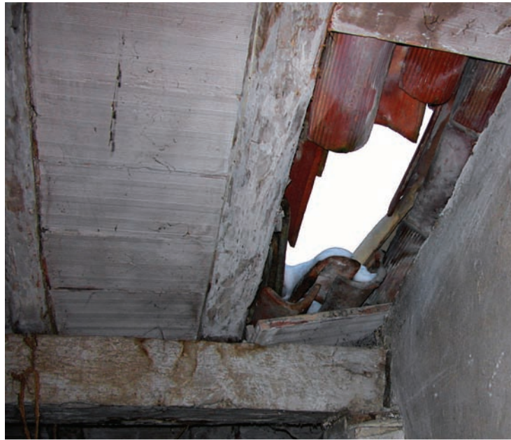
Foto 14 Barbiano (Felino): crollo parziale in un edificio rurale in precarie condizioni. Photo 14 Barbiano (Felino): partial collapse in a badly maintained rural building.
