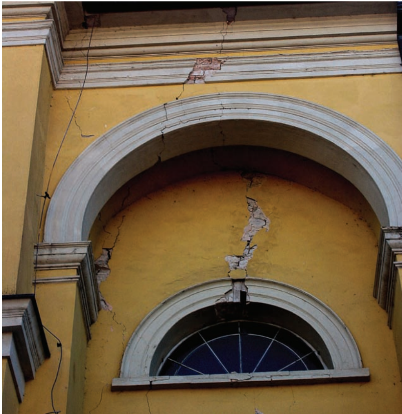
Foto 8 San Vitale di Baganza (Sala B.): chiesa con lesioni passanti. Photo 8 San Vitale di Baganza (Sala B.): large cracks in the Church wall.
