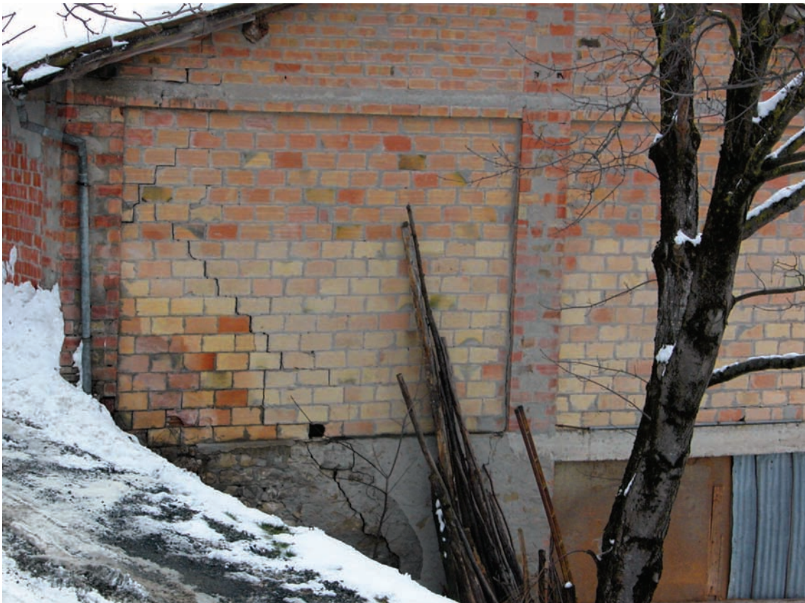
Foto 30 Vezzano (Neviano degli Arduini); lesione passante. Photo 27 Vezzano (Neviano degli Arduini); large crack in the wall.
