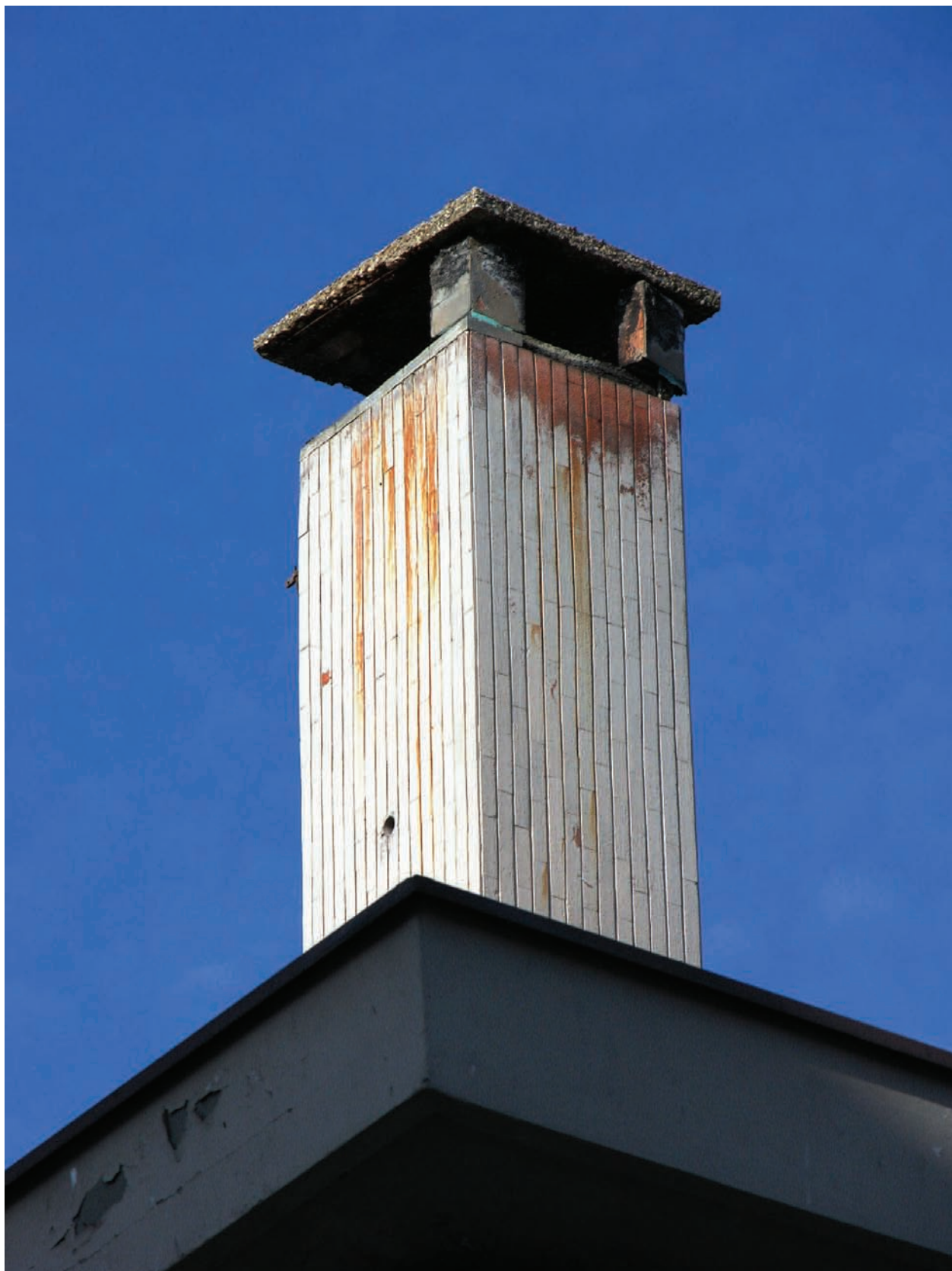
Foto 7 San Vitale di Baganza (Sala B.): caduta e spostamento di pietre nella parte sommitale di una ciminiera. Photo 7 San Vitale di Baganza (Sala B.): fall and rotation of stones on the top of the chimney.
