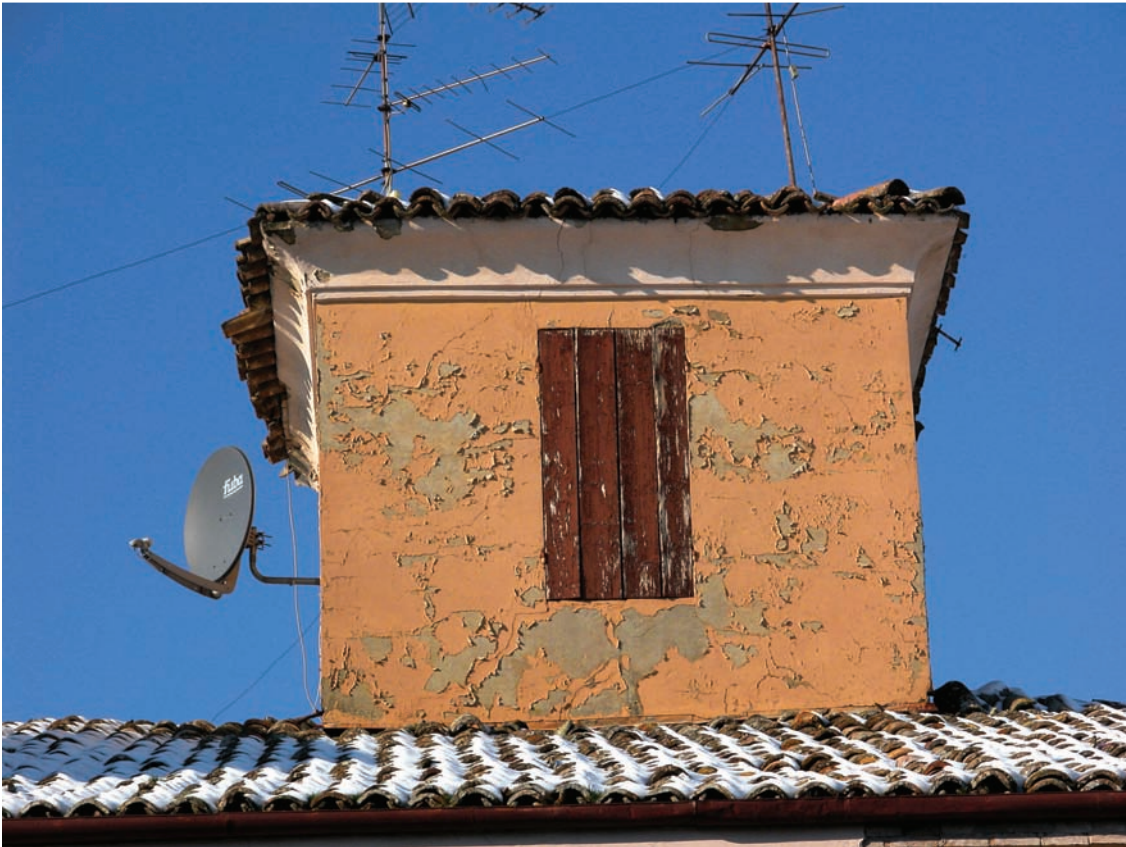
Foto 1 Sala Baganza: scivolamento di tegole. Photo 1 Sala Baganza: Sliding of tiles.
