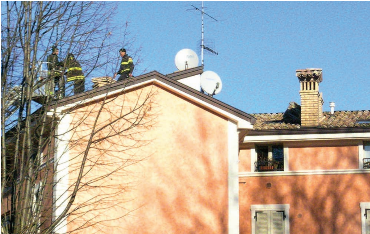
Foto 16 Langhirano: camini danneggiati e pericolanti. Photo 16 Langhirano: damaged chimneys.
