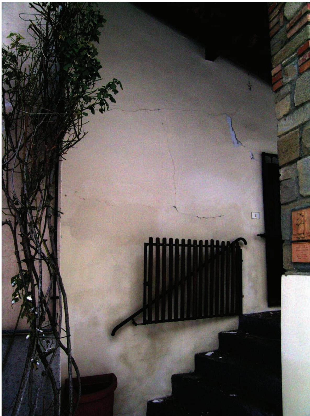
Foto 28 Terenzo: lesioni in edificio in muratura nel centro del paese. Photo 28 Terenzo: cracks in a masonry building in downtown.
