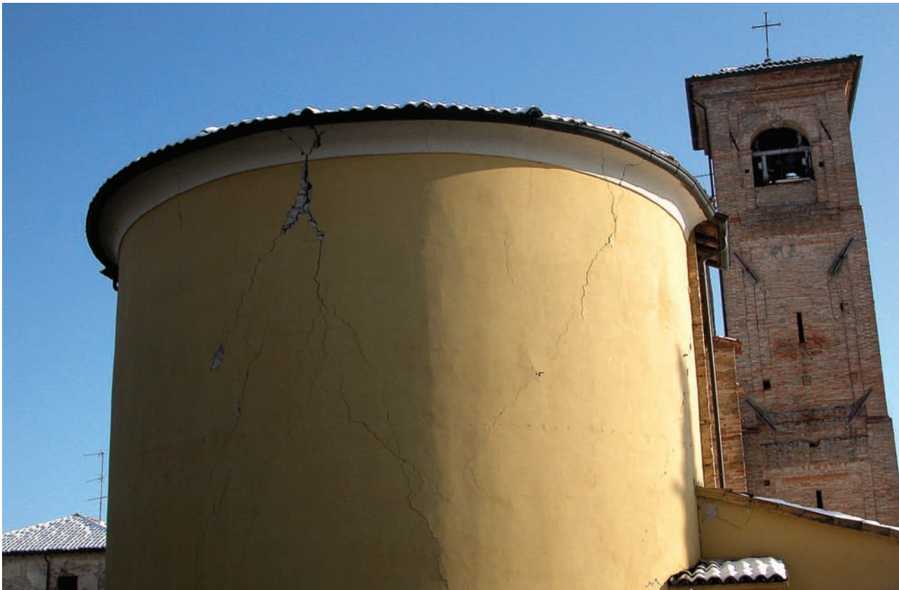
Foto 9 San Vitale di Baganza (Sala B.): chiesa, lesioni passanti parte sommitale esterna dell'abside. Photo 9 San Vitale di Baganza (Sala B.): Church, large cracks in the upper part of the apse.
