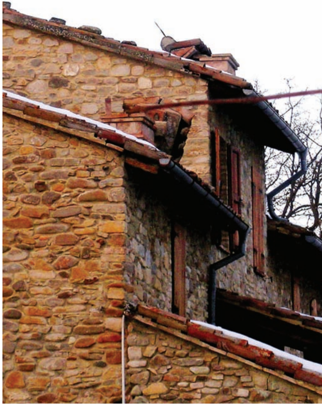
Foto 19 Castello di Torrechiara (Langhirano): caduta di camini in un edificio del borgo. Photo 19 Castello di Torrechiara (Langhirano): collapse of chimney of a building in the village.
