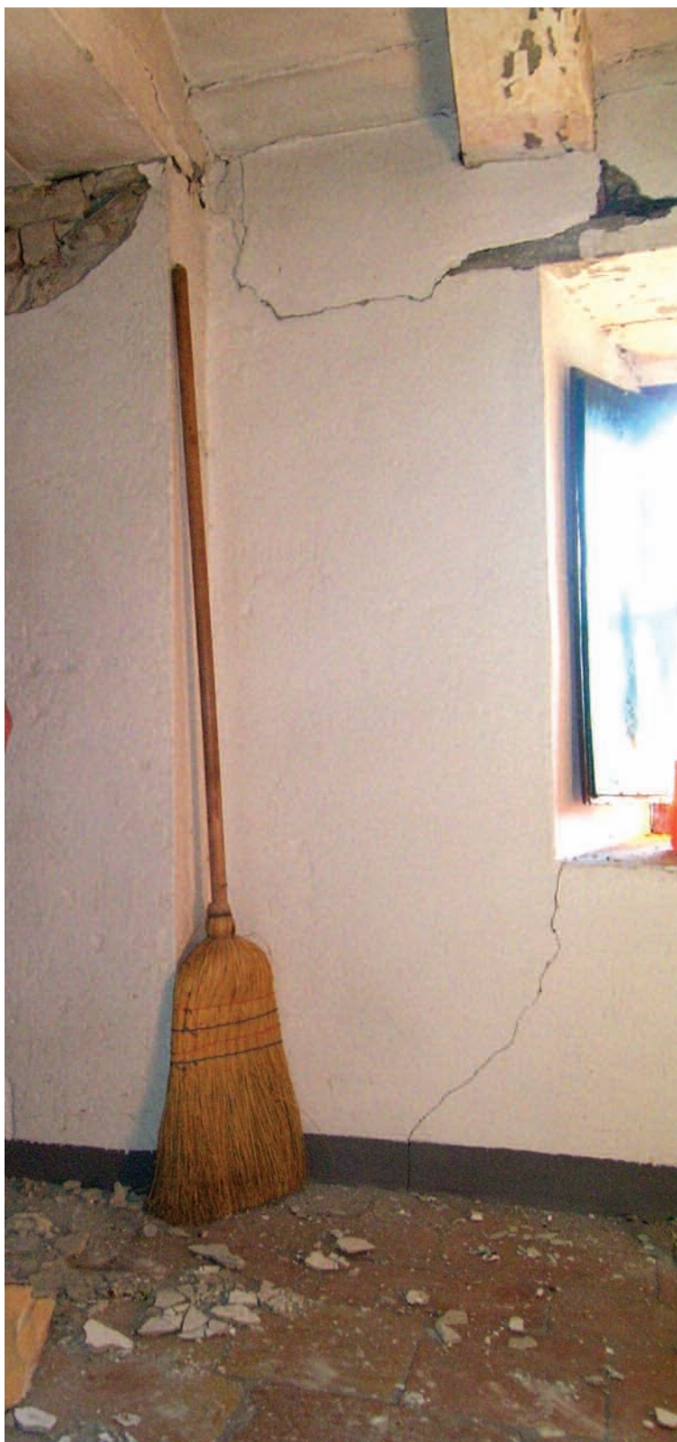
Foto 18 Fragno (Calestano): Lesioni a un edificio in muratura. Photo 18 Fragno (Calestano): cracks in a poor masonry building.
