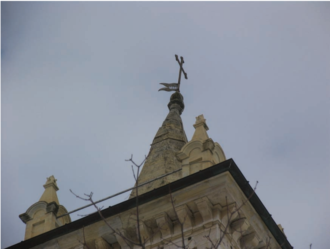
Foto 29 Vezzano (Neviano degli Arduini); chiesa, rottura della parte sommitale della torre campanaria. Photo 29 Vezzano (Neviano degli Arduini); failure of the top of the pinnacle in the parish church.
