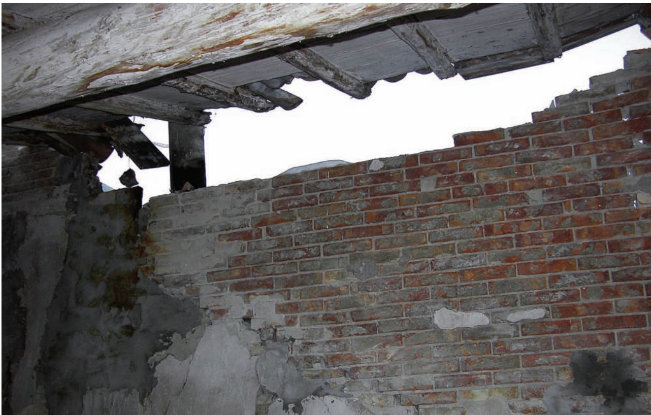
Foto 13 Barbiano (Felino): crollo parziale in un edificio rurale in precarie condizioni. Photo 13 Barbiano (Felino): partial collapse in a badly maintained rural building.
