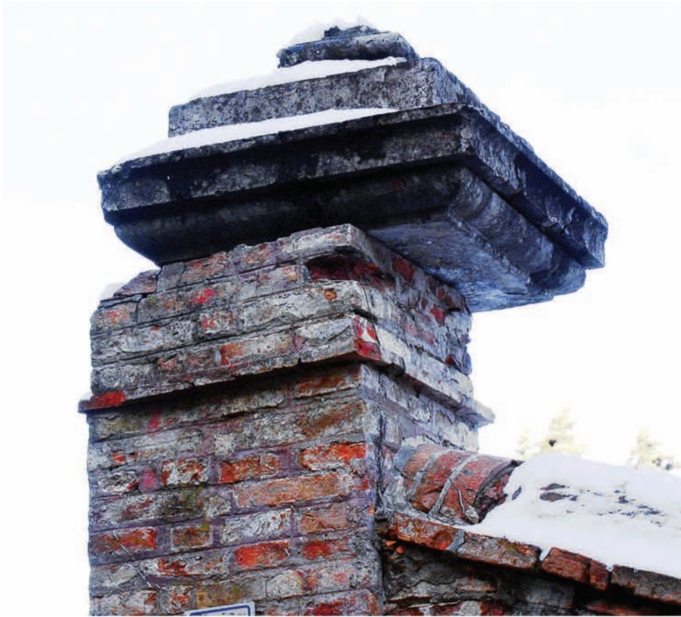
Foto 12 San Vitale di Baganza (Sala B.): slittamento e parziale rotazione del capitello di una colonna in un muro di recinzione. Photo 12 San Vitale di Baganza (Sala B.): sliding and partial rotation of the capital of a wall.
