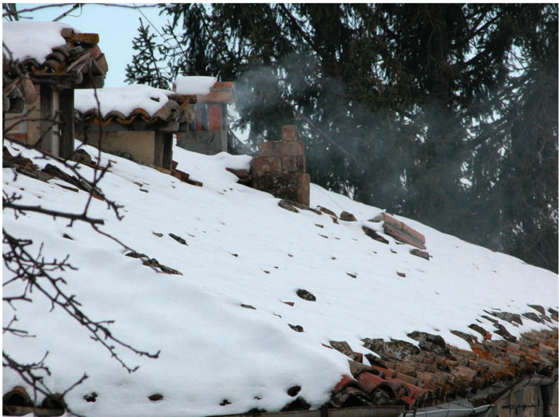
Foto 25 Neviano degli Arduini: rottura di camino. Photo 25 Neviano degli Arduini: failure of a chimney.
