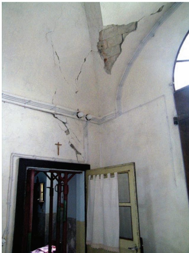
Foto 2 San Michele de' Gatti (Felino): lesioni interne. Photo 2 San Michele de' Gatti (Felino): Cracks in internal walls.
