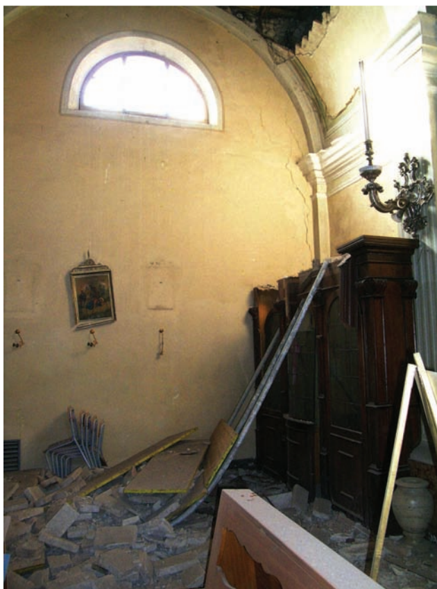
Foto 21 Mamiano (Traversetolo): chiesa inagibile per crollo della volta in una cappella laterale. Photo 21 Mamiano (Traversetolo): partial collapse of the vault in a lateral chapel.
