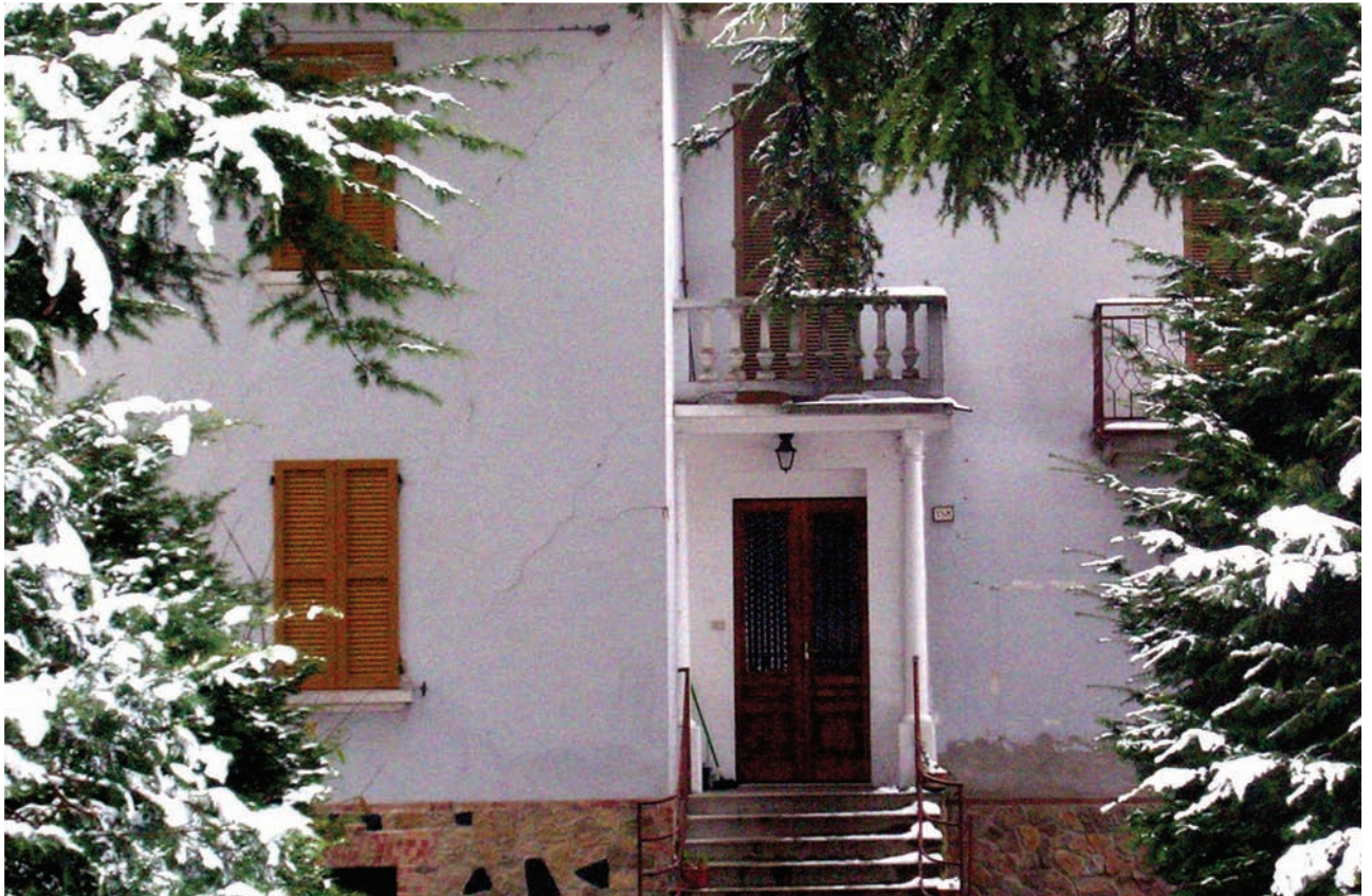
Foto 3 Poggio Sant'Ilario (Felino): lesioni a X sulla facciata di un'abitazione in muratura. Photo 3 Poggio Sant'Ilario (Felino): X cracks on a masonry building.
