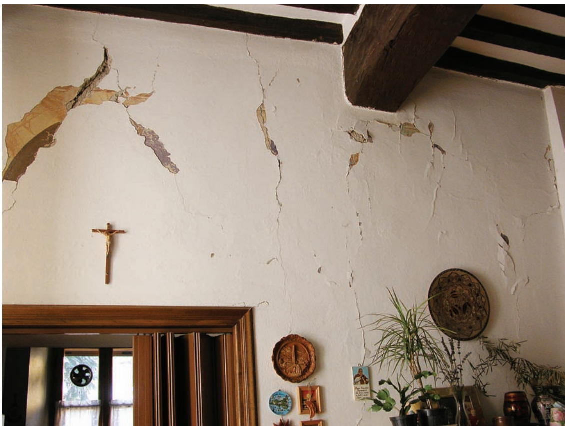
Foto 11 San Vitale di Baganza (Sala B.): edificio privato, lesioni diffuse, distacco di intonaco. Photo 11 San Vitale di Baganza (Sala B.): extensive cracks with fall of plaster in private building.
