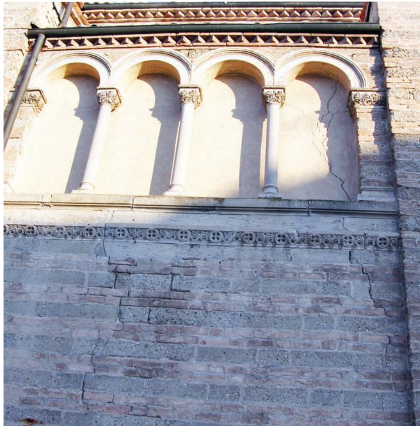
Foto 24 Montechiarugolo: lesioni alla chiesa. Photo 24 Montechiarugolo: cracks in the church.
