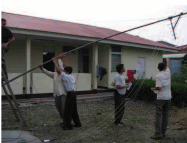
Figura 10 Foto del momento dell'installazione del palo delle antenne UHF che si possono notare all'estremità. Figure 10 Photo of installation operation of the pile of UHF antennas which can be seen at the top.
