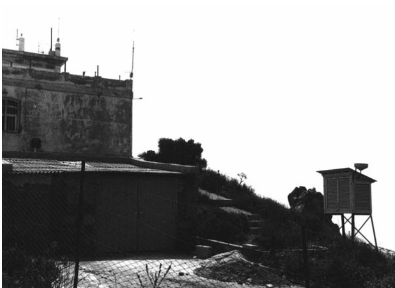
Figura 16 In evidenza la stazione meteo (nella capannina a destra), posizionata in prossimità di quella sismica.
