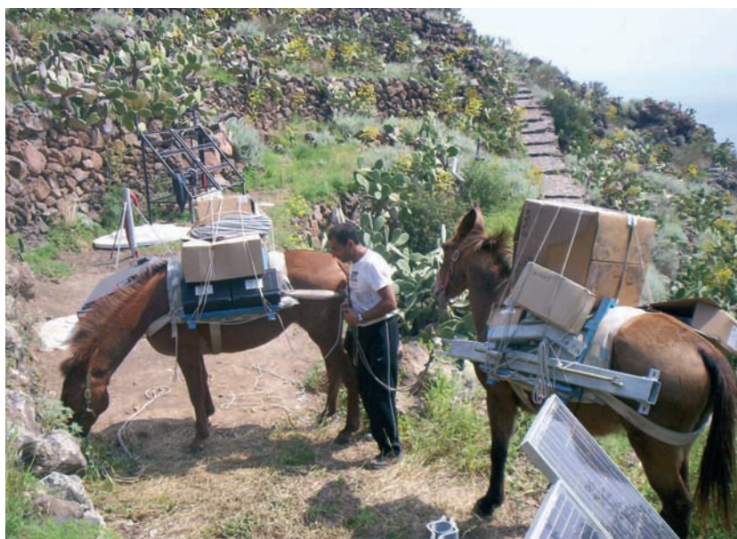
Figura 17 Installazione della nuova stazione sismica digitale di Alicudi (IACL). Maggio 2007.
