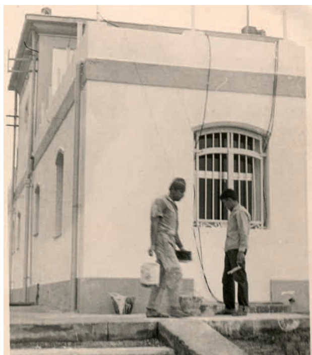
Figura 4 Il personale dell'Osservatorio durante la ristrutturazione dell'edificio nel '67 (da sinistra Angelo Biviano e Mario Marturano). Figure 4 Observatory staff busy in the restructuring of the building, in '67 (from left Angelo Biviano and Mario Marturano).
