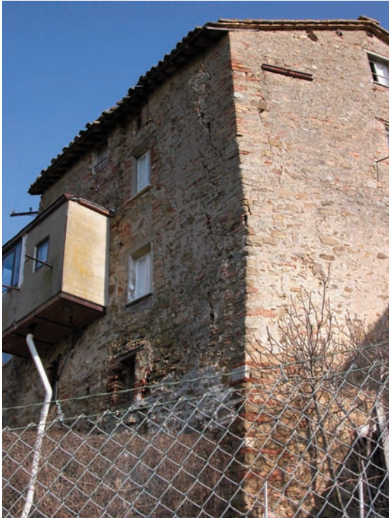
Foto 10 Sant'Apollinare (Marsciano, PG), cedimento dello spigolo in edificio in muratura mista ( d3 ). Photo 10 Sant'Apollinare (Marsciano, PG), failure of the corner in a masonry building ( d3 ).
