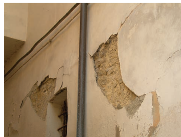
Foto 9 San Biagio della Valle (Marsciano, PG), caduta di larghi pezzi di intonaco (d2).
