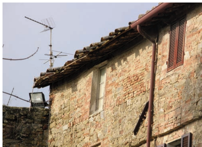
Foto 2 Spina (Marsciano, PG), slittamento e caduta di tegole ( d3 ). Photo 2 Spina (Marsciano, PG), sliding and fall of tiles ( d3 ).
