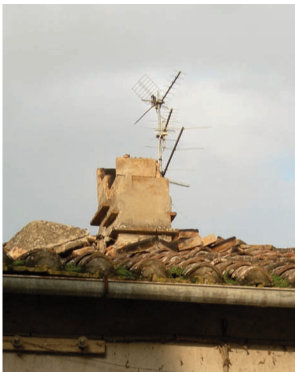
Foto 7 San Biagio della Valle (Marsciano, PG), rottura del camino (d2).
