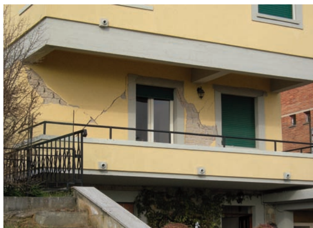
Foto 6 Spina (Marsciano, PG), lesioni a croce in muri di tamponatura (d3). Photo 6 Spina (Marsciano, PG), cracks in infill walls (d3).
