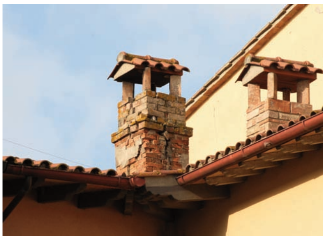
Foto 1 Spina (Marsciano, PG), camino fratturato ( d2 ). Photo 1 Spina (Marsciano, PG), cracked chimney ( d2 ).
