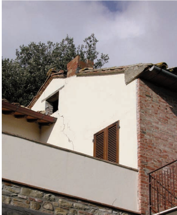
Foto 11 Sant'Apollinare (Marsciano, PG), lesione passante sul muro perimetrale ( d3 ). Photo 11 Sant'Apollinare (Marsciano, PG), large crack on external wall ( d3 ).
