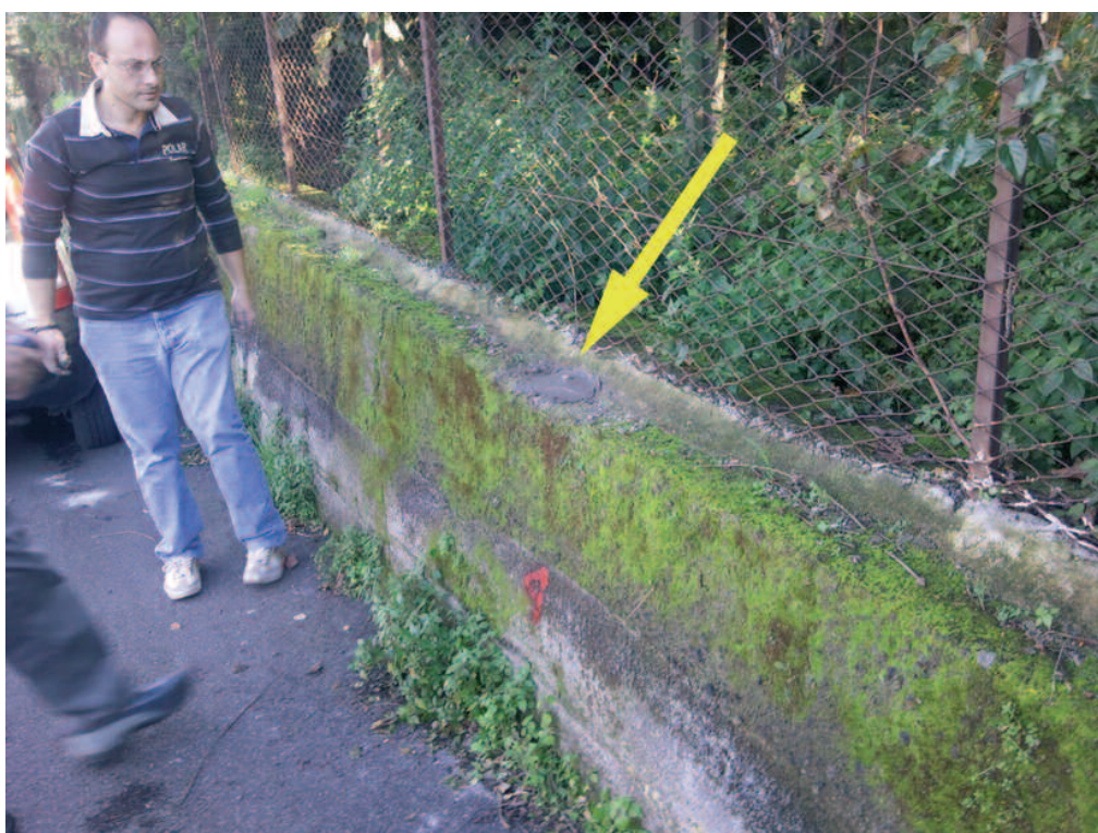
Figura 8 Esempio di installazione di un caposaldo di tipo a calotta sferica (verticale), materializzato su un manufatto in calcestruzzo armato. Figure 8 Monumentation of a spherical cap benchmark (vertical), installed on a reinforced concrete manufact.
