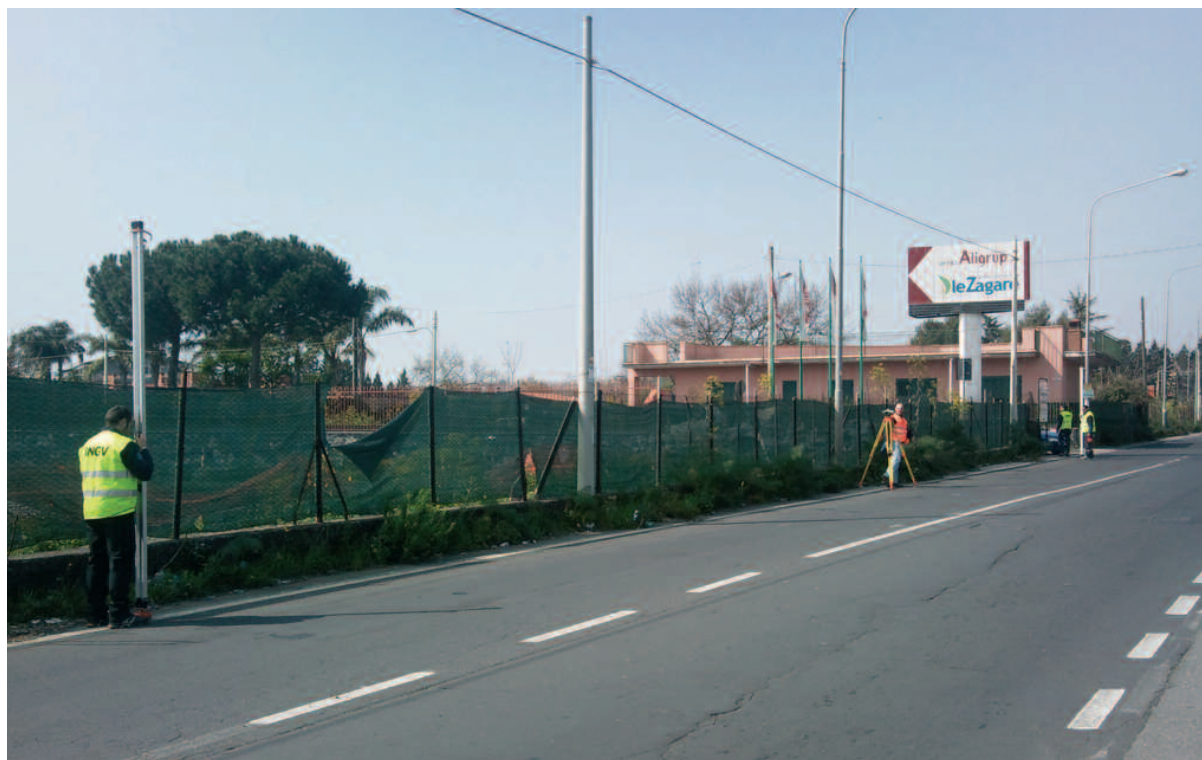
Figura 11 Esecuzione delle misure tramite livellazione geometrica dal mezzo. Figure 11 Example of measurement carried out by geometric leveling with equal distances.
