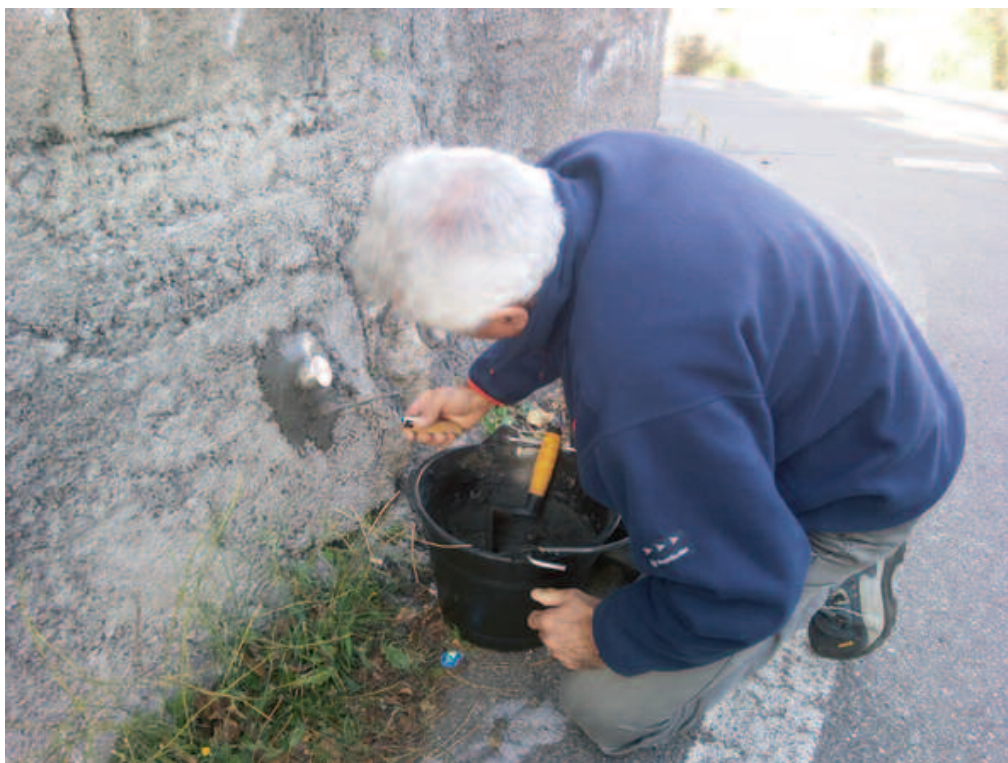
Figura 7 Esempio di installazione di un caposaldo di tipo a forma torica (orizzontale), materializzato su un manufatto in calcestruzzo armato. Figure 7 Monumentation of a toric benchmark (horizontal), installed on a reinforced concrete manufact.
