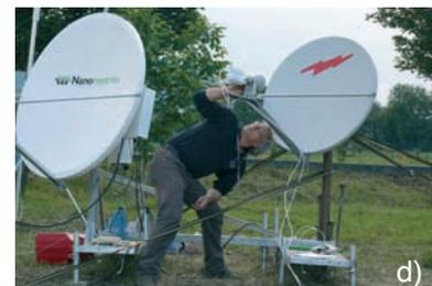
**Figura 2** Allestimento interno della tenda ed infrastruttura di comunicazione satellitare.
