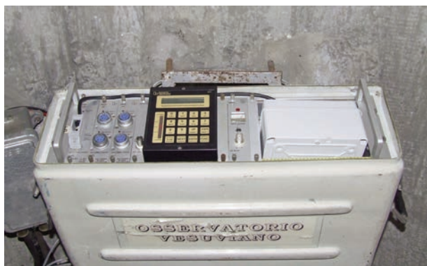
Figura 22 Stazione Lennartz PCM 5800 installata presso il sito di Bunker Sud, versante meridionale del Gran Cono del Vesuvio. Sulla destra è inserito il contenitore del registratore Sony Minidisc HiMD [da Castellano et al., 2007].
