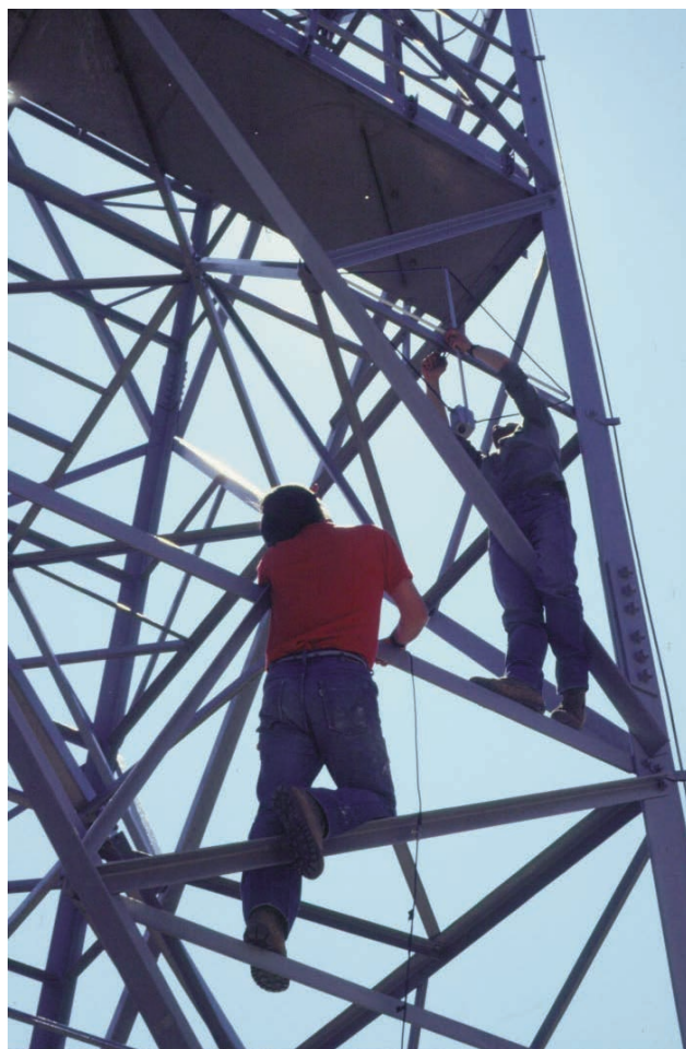
Figura 66 Installazione dell'antenna loop per la ricezione del segnale del tempo DCF77 sul traliccio della centrale SIP (foto G. Vilardo). Figure 66 Installation of the DCF77 loop antenna on the SIP pylon (photo G. Vilardo).
