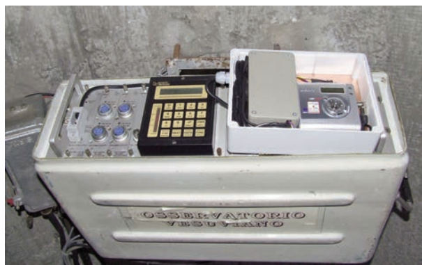
Figura 23 Come figura 22. Si può notare l'ingegnerizzazione dell'apparato di registrazione Sony HiMD con la scatola grigia contenente l'elettronica di controllo. Il contenitore, a tenuta stagna, è stato coibentato a causa dei limiti termici di funzionamento dei registratori MiniDisc [da Castellano et al., 2007].
