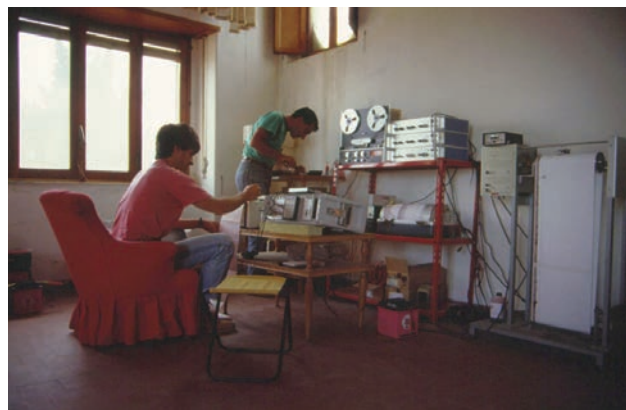
Figura 60 Catena di decodifica del sistema Lennartz PCM 5800 installata presso la centrale di acquisizione di San Gregorio (foto G. Vilardo). Figure 60 Lennartz PCM 5800 decoding system installed at the acquisition center of San Gregorio (photo G. Vilardo).
