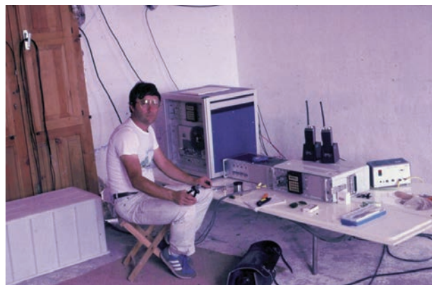
Figura 49 Installazione della centrale di acquisizione (foto G. Vilardo).
