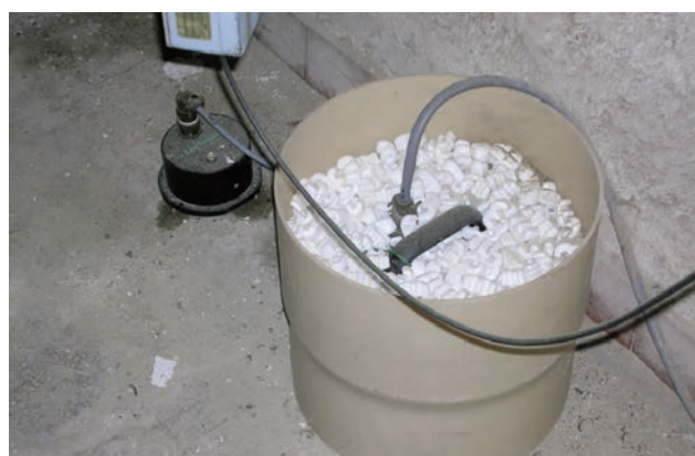
Figura 75 Sismometro Guralp CMG-40T (parzialmente coibentato) ed accelerometro Episensor ES-T installati presso la stazione di Trecase (foto D. Galluzzo).
