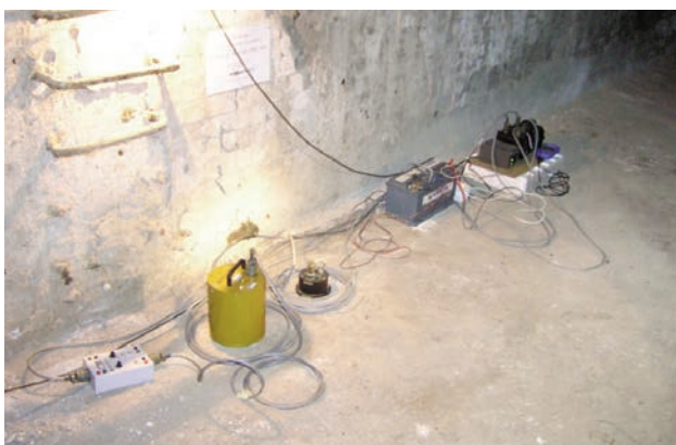
Figura 93 Stazione multi sensore di CELB (Pozzuoli). Ad un acquirente Reftek 130-01 a sei canali sono collegati un sismometro Geotech KS-2000 ed un accelerometro Kinematics EpiSensor FBA ES-T (foto D. Galluzzo).
