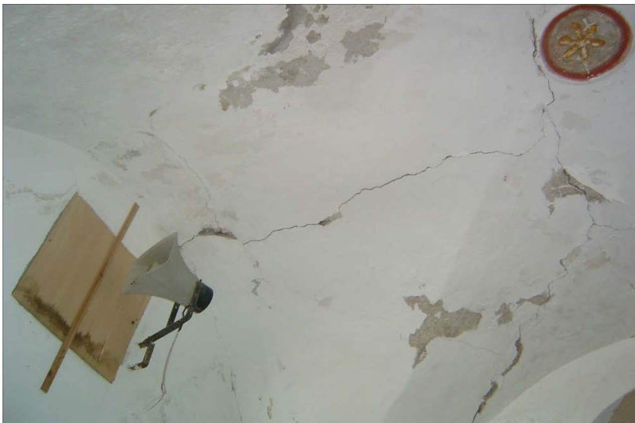
Foto 5 Chiesa di S. Salvatore: lesioni e caduta di calcinacci nella parte dell'abside. Photo 5 S.Salvatore Church: fall of pieces of plaster and cracks in the vault of the apse.
