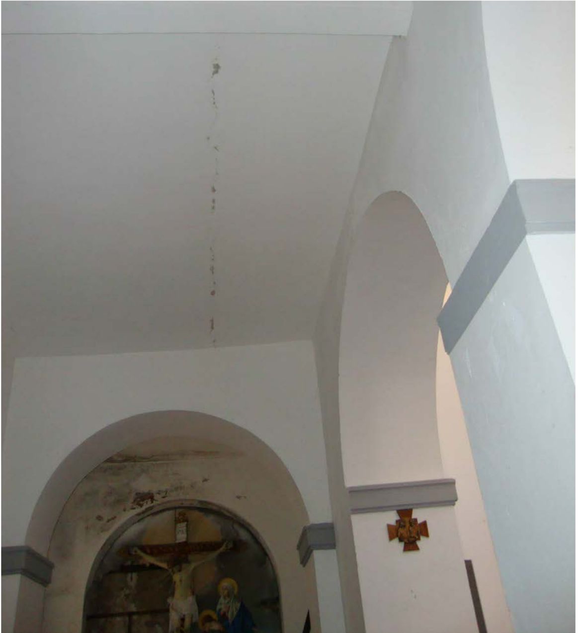
Foto 8 Galati Mamertino: Chiesa del Rosario. Frattura longitudinale nell'intonaco del tetto della navata laterale sinistra. Photo 8 Galati Mamertino: Church of the Rosary. Cracks in the plaster of the roof in the left-hand aisle.
