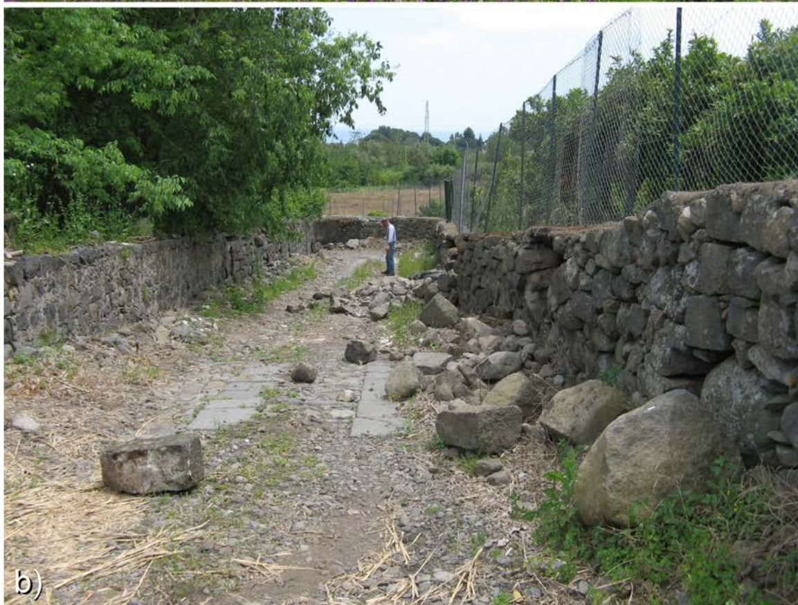
Foto 1 S. Matteo: a) rottura muraria per l'azione spingente del tetto in un vecchio edificio in muratura "a sacco" (cl. A); b) crollo di muri a secco lungo una strada interpoderale. Photo 1 S. Matteo: a) damage due to the load action of the roof in a typical edifice built in fieldstone with very weak mortar (vulnerability class A); b) collapse of the walls bordering a cart track.
