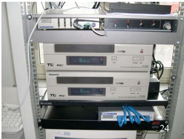
**Figura 24.** Il sistema di videoregistrazione analogico mediante apparati time-lapse.
