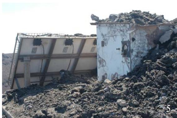
**Figura 4 e 5.** Immagini della telecamera di sorveglianza Sony e dello shelter contenente il sistema di trasmissione e di alimentazione dopo l'esplosione del 5 Aprile.
