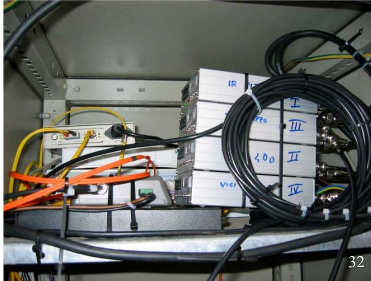
**Figura 32.** Sistema di demodulazione a 2 Ghz e sistema di trasmissione per fibra ottica.
