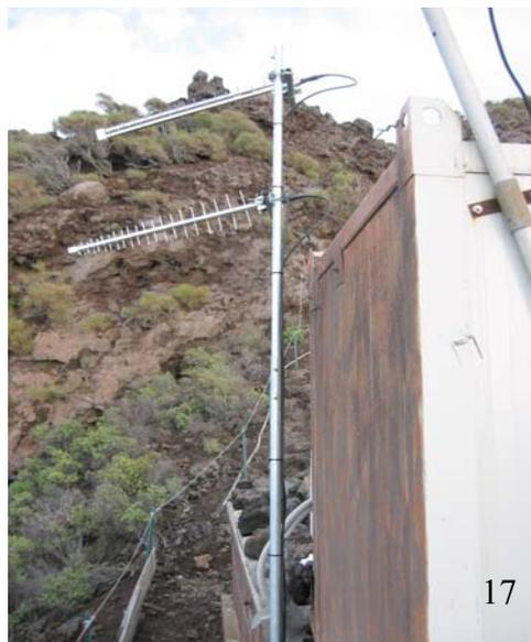
**Figura 17.** Le due antenne di trasmissione di quota 400 m s.l.m..
