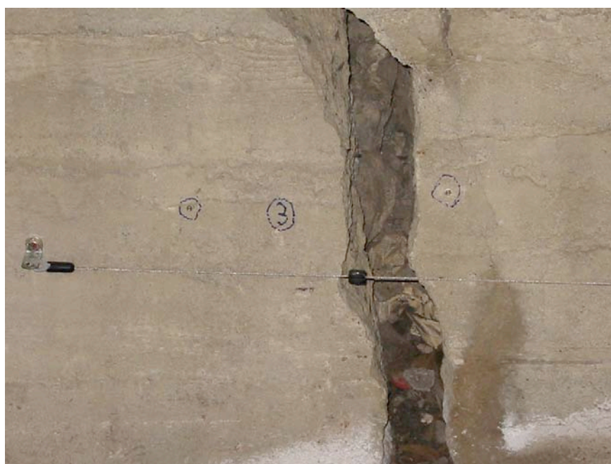
Figura 5 Particolare della coppia di dischetti n° 3 installati a ridosso dell'estensimetro a filo Et2.
