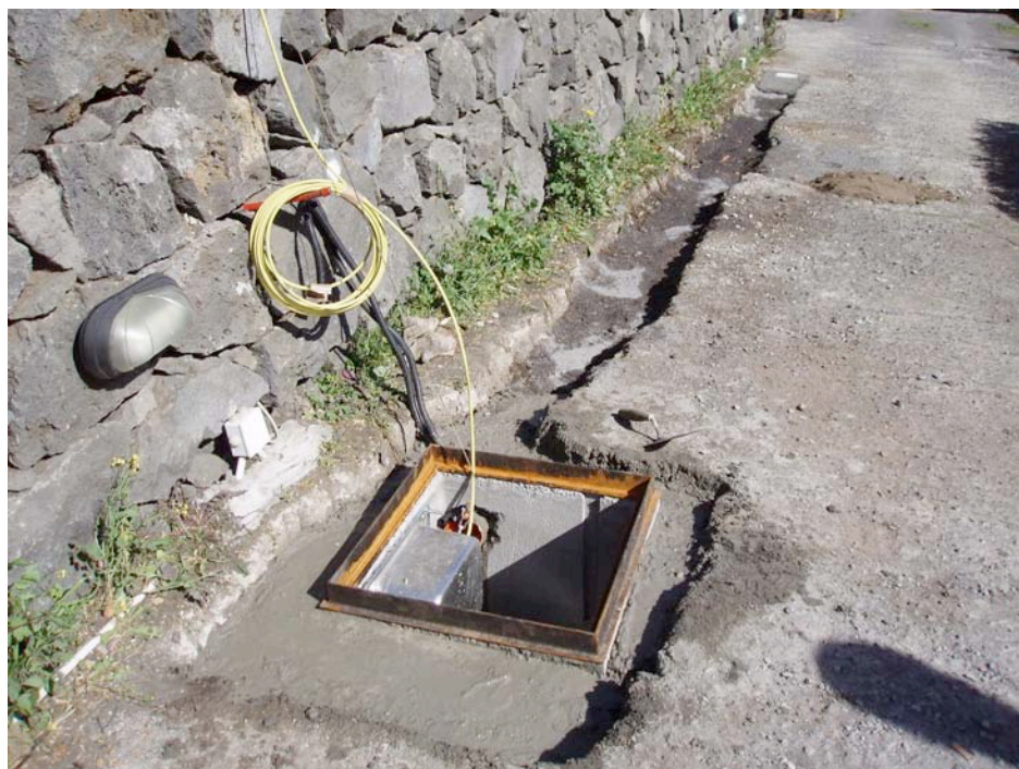
Figura 3 Foto installazione estensimetro ET3.
