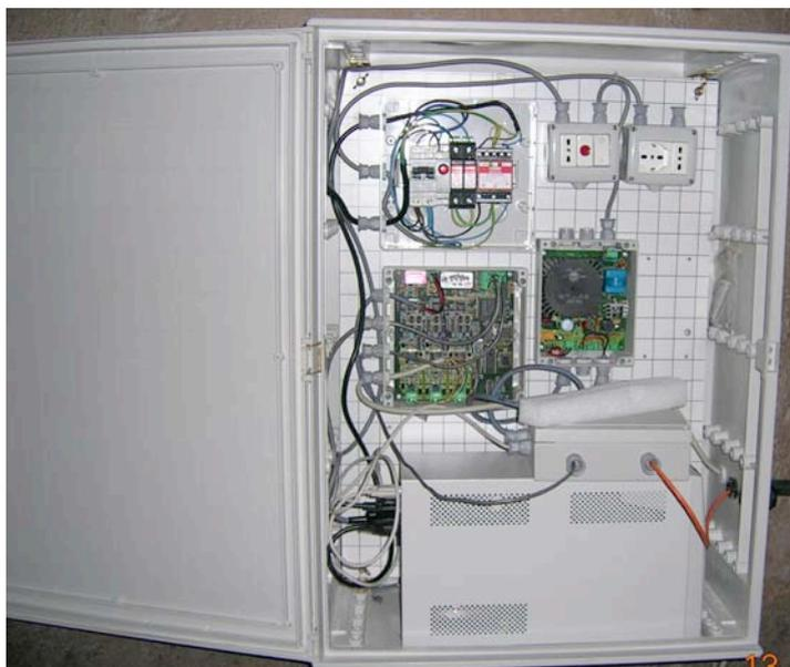
Figura 9: esempio di installazione dentro box Gewiss
