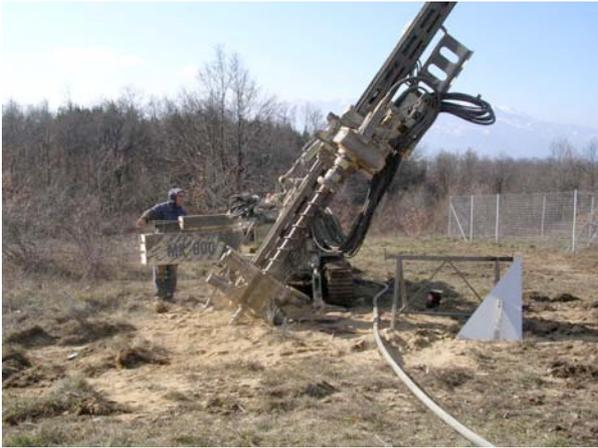
**Figura 6** La foto evidenzia la fase di trivellazione di uno dei fori laterali del tripode profondo della stazione di Busso (BSSO).
