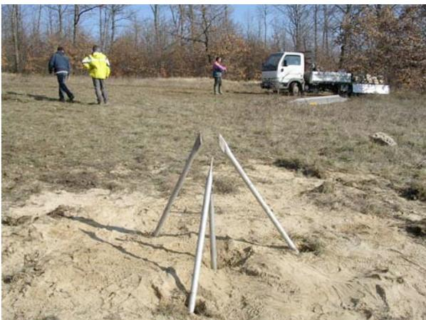
**Figura 7** La foto evidenzia le quattro aste all'interno dei fori prima di essere saldate e cementate.
