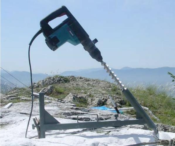
**Figura 21** Guida di foraggio posizionata per la realizzazione dei fori obliqui.
