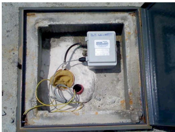
Figura 5. Particolare di uno dei fori dopo l'installazione del clinometro.
