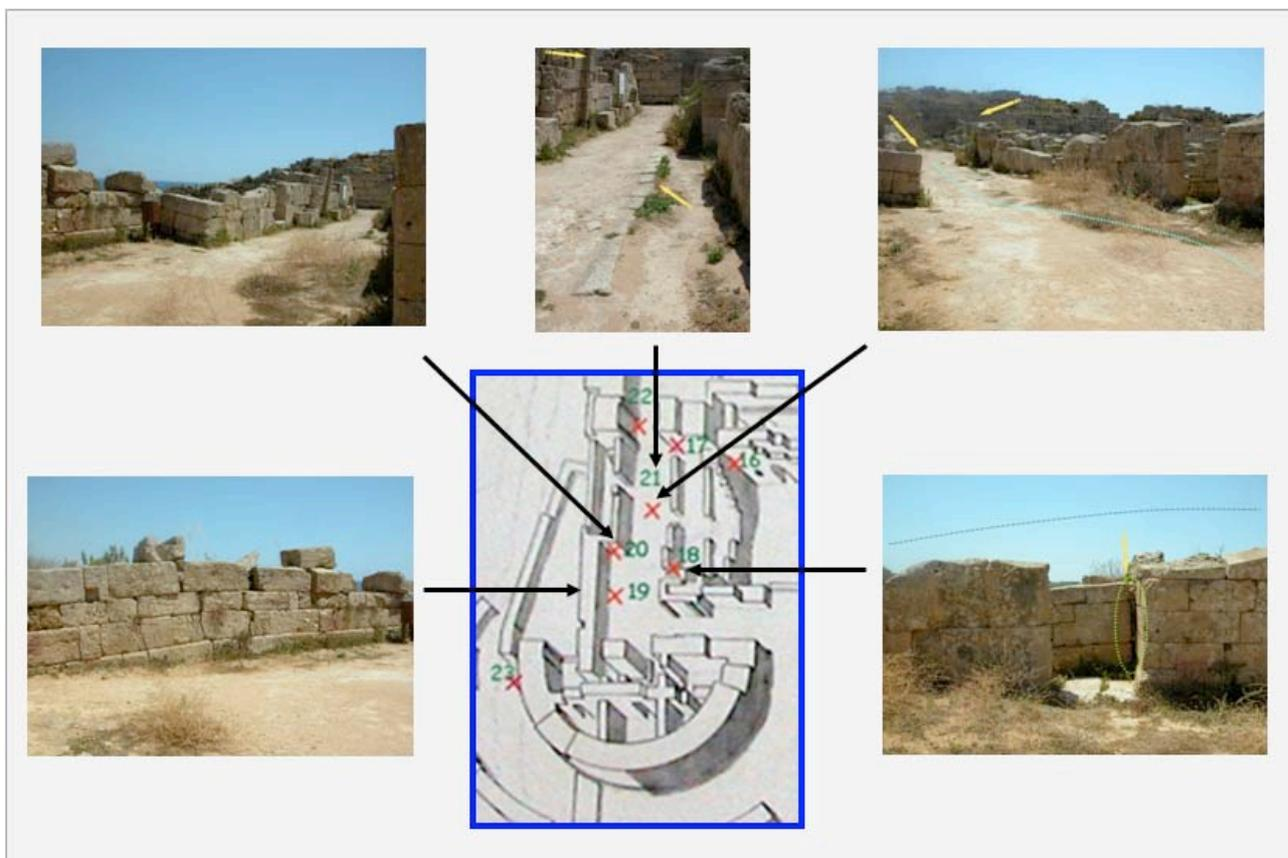
**Figura 16.** Punti di misura 18, 19, 20, 21: panoramica dell'asse stradale del camminamento epimurale tra il torrione nord e la Porta XVIII. Si notano evidenti spinte verso l'interno (freccie gialle), un innalzamento del piano di calpestio (linea celeste) e della crepidine della pavimentazione stradale (freccia gialla).
