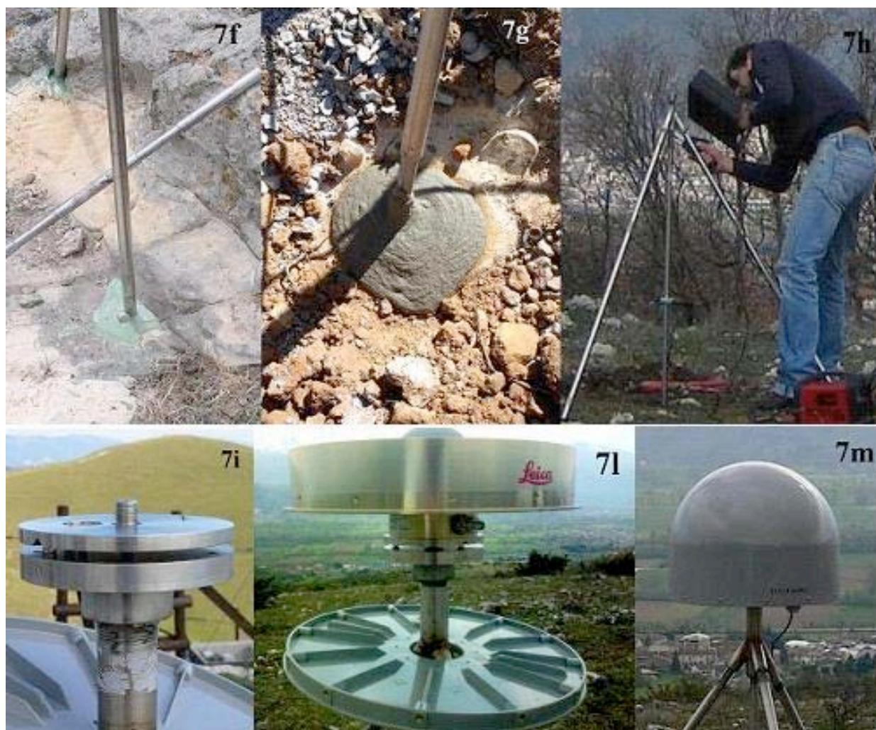
**Figura 7 (f, g, h, i, l, m).** Fasi di installazione del monumento GPS permanente tipo *short-drilled-braced*. Per i dettagli si veda il testo.
