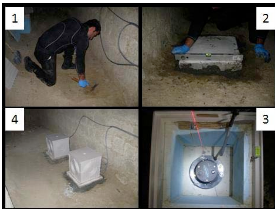
Figura 8 Fasi di installazione del velocimetro e dell'accelerometro. 1) Scavo. 2) Posa del massetto in cemento. 3) Orientazione del sensore accelerometrico. 4) Installazione completa.
