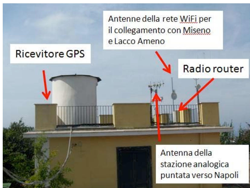
Figura 10. Il tetto del padiglione storico che ospita la vasca sismica e la "sala della meridiana". Sono indicati i sistemi per la trasmissione dei dati installati da OV-INGV e la posizione del ricevitore GPS.
