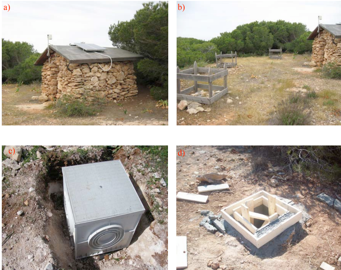
Figura 1. a) mostra la casa in pietra dell'Osservatorio di Lampedusa in cui sono visibili i pannelli solari e l'antenna GSM del modem; b) mostra i tre pozzetti in cui sono collocabili gli strumenti; c) e d) mostrano due momenti della realizzazione dei singoli pozzetti sensori in P.V.C.
