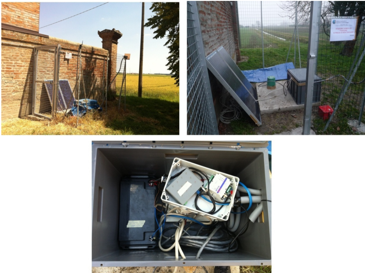
Figura 9. Quadro d'insieme della stazione accelerometrica FERS installata presso il cimitero di Casaglia (FE). In alto a sinistra sono osservabili, oltre i pannelli solari (dal 17/10/2013 la stazione è alimentata a corrente continua 220V), l'antenna GSM/GPRS del Nethix (più a sinistra) e l'antenna direzionale 3G HSPDA/UMTS da15dBi ( www.theta-communication.com ) dell'UR5 (più a destra). In alto a destra si riconosce la soletta di cemento armato sul quale è ancorato l'accelerometro (protetto dal cappello verde) e la scatola contenente l'acquisitore. In basso: dettaglio della scatola contenente il dispositivo Nethix WE120, il router UR5 (alloggiati nel medesimo box), la batteria tampone e l'acquisitore GAI A2.
