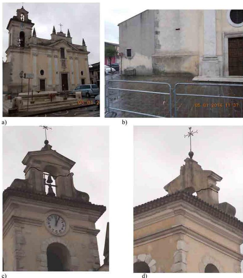
**Figura 4.** Danni alla torre campanaria della Cattedrale. Livello di danno stimato D3-Grave. Le lesioni nelle foto c) e d) sono state graficamente evidenziate.
