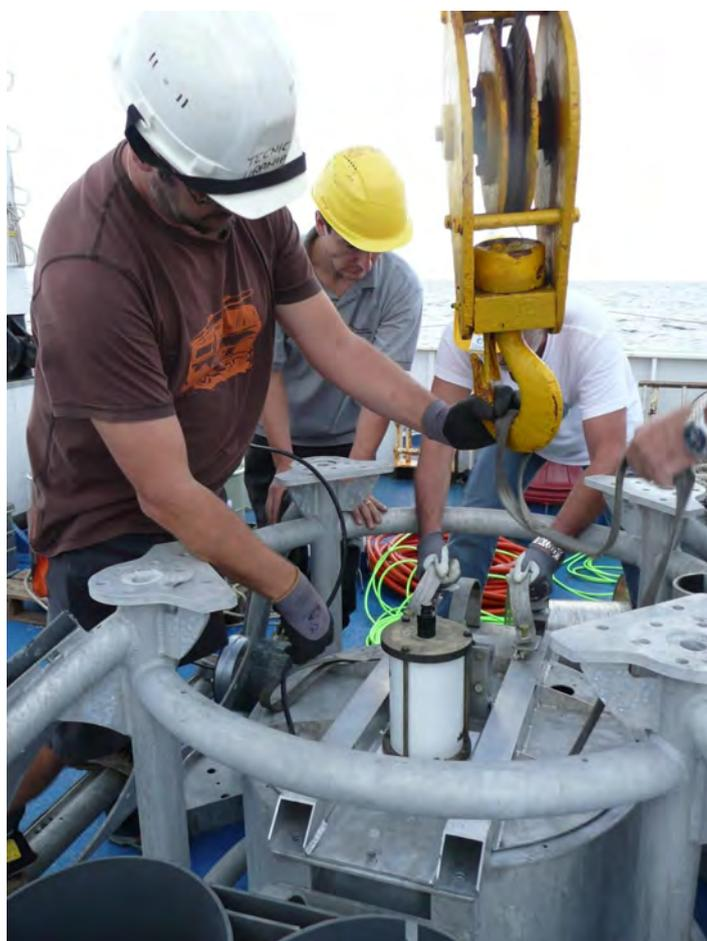
*Personale INGV impegnato nell'assemblaggio dei sistemi osservativi di una piattaforma prima della sua posizionamento a fondo mare. In particolare nell'immagine si osserva l'allestimento dell'osservatorio sottomarino SN4 nel Mare di Marmara a bordo della nave oceanografica URANIA. Il nodo SN4 è in grado di fornire parametri oceanografici sismologici e di emissione di gas metano utili a comprendere le relazioni tra emissioni dal fondale di gas e sismicità (foto di repertorio INGV).*
