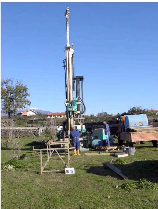
Fig. 3. Fase dell'esecuzione del foro di sondaggio geognostico.
